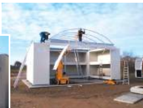
Posizionamento dei contenitori e installazione della struttura dei tetti.
