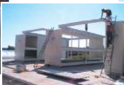
Posizionamento dei contenitori e installazione della struttura dei tetti.
