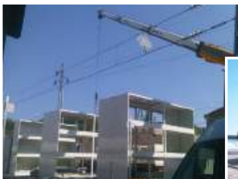
Posizionamento dei contenitori e installazione della struttura dei tetti.
